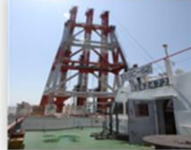
深層水泥拌合 (前期測試)
